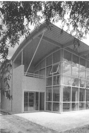
Maison domotique à Chambray-lès-Tours, 1990; architecte, Jean-Yves Barrier.
