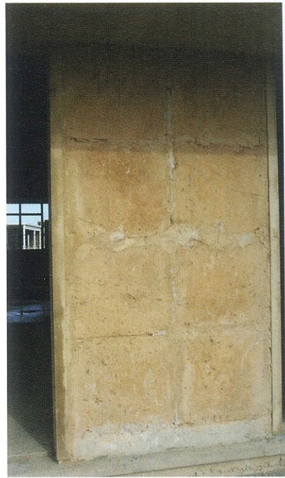
Les éléments préfabriqués en bauge ont 50 cm d'épaisseur et 70 cm de hauteur.
