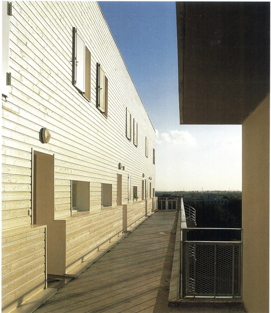
Les duplex des étages supérieurs ont une ossature en bois.
