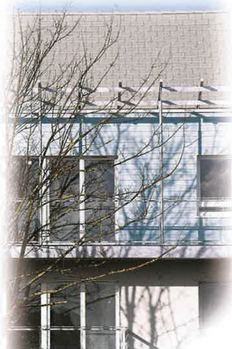
Les Brandons : un des premiers chantiers en tuiles contemporaines
