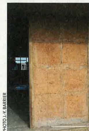
La résidence Salvatierra à Rennes (35) est en partie construite en bauge, un mélange de terre crue et de paille.
