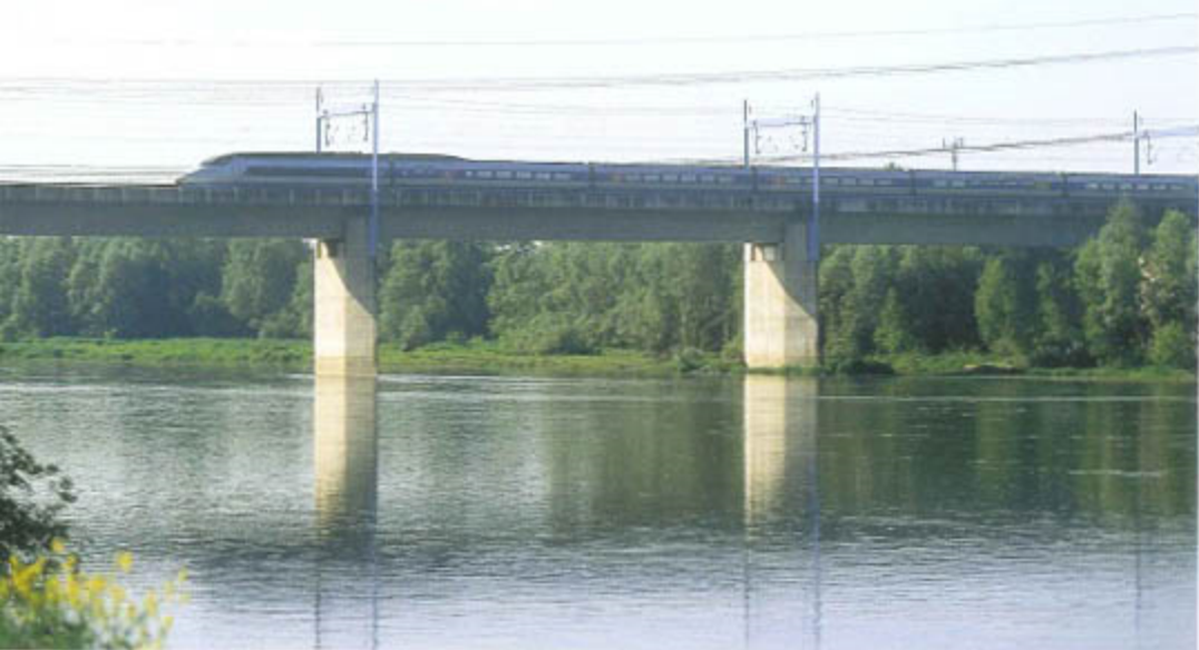
Montlouis-sur-Loire, le pont du TGV.
