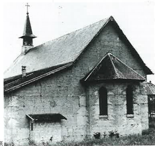
La chapelle rurale de Bordenoud, construite à Dolomieu (Isère) au XIX e siècle, est un des rares édifices religieux européens en pisé.
