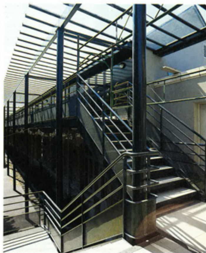
Surélévation de l'école primaire de Saint-Pierre-des-Corps : une passerelle métallique dessert les classes.
