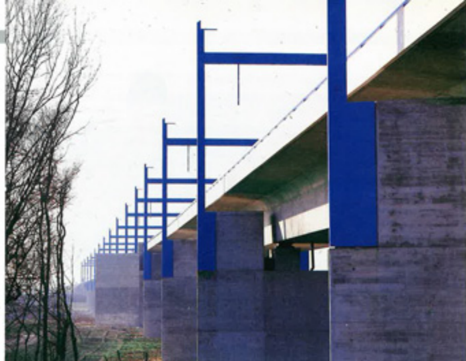
Le viaduc du TGV au-dessus de la Loire : un pont de 800 m de long.
