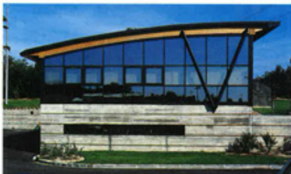
Siège de la Compagnie Générale des Eaux à Sainte-Maure de Touraine (Indre-et-Loire), 1990.
