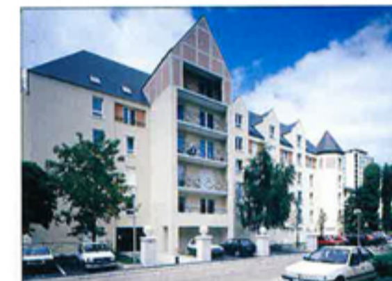
Productions locales et filiales autonomes : ici, à Tours, avec des toits (Bastie, architecte).
