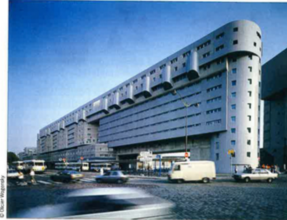
Ensemble multifonctionnel de la Villette Nord adossé à la Cité des sciences et de l'industrie à Paris (Gérard Thurnauer, architecte).
