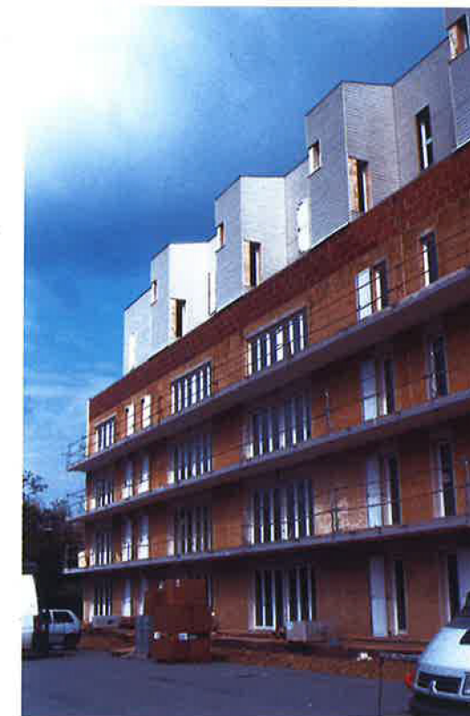
Immeuble « Salvatierra », pays de Rennes, 2002.
