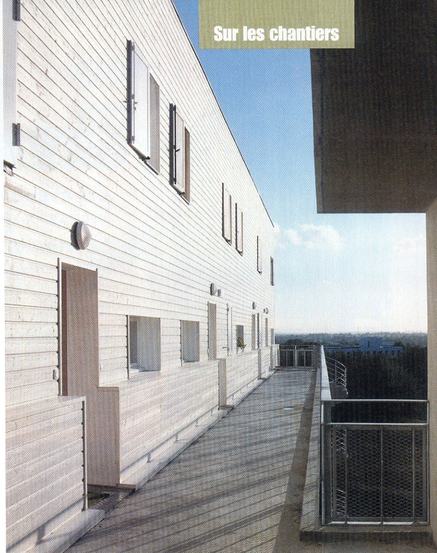
DES CLINS D'ÉPICÉA PEINTS, en haut à gauche et ci-dessus, et un composite fibres de bois et ciment (là où un classement au feu MO est exigé) habillent trois des façades de cet ensemble. (Doc.)
